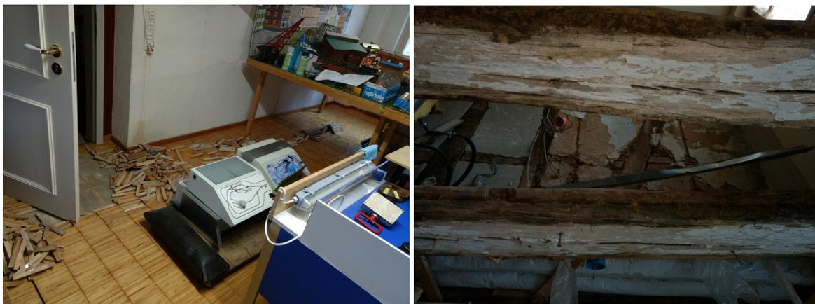
**Bild links:** Das hochgedr ckte Parkett unmittelbar nach dem Wasserschaden Anfang September 2020
